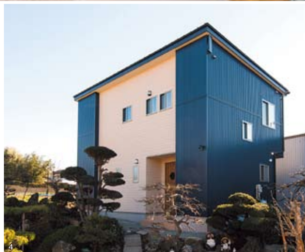
1.家族全員で塗装したカウンターは「家づくりのいちばんの思い出。大変だったけど、愛着が湧きました」(奥様)。 2.キッチンカウンターの下がり壁にかかるペンダントライトが雰囲気を演出。 3.奥にシューズクロークを備えた、広い土間のある明るい玄関。 4.木目調のサイディングと紺のガルバリウムを組み合わせた外観。 ※以上全て、前橋市S邸
